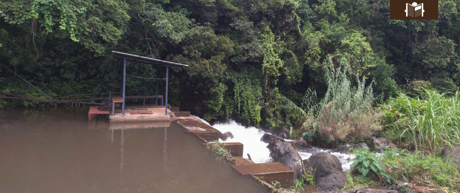
Le barrage hydraulique de la JIRAMA tirant sa source de la rivière de Besokatra
